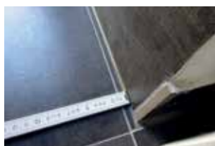
Dořez u prvního schodu.
