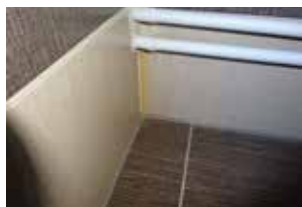
Plastová lišta, potrubí topení a šedá obvodová spára.
