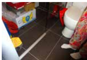
Netěsnící sprchová zástěna.
