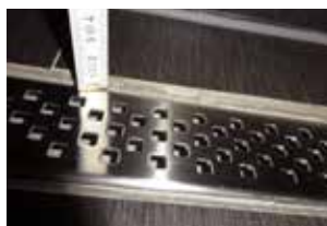
Nepěkný detail odtokového žlabu ve sprše.
