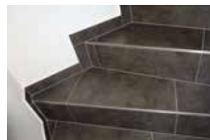
Schodiště – pohled ze zdola.
