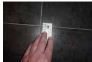
Opět příliš úzké spáry, které vedou k vadám.
