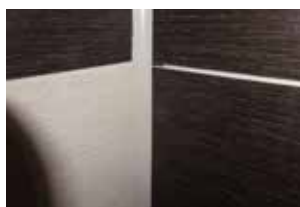
Nevzhledné lišty a nevyplněná spára (důsledek úzké spáry).
