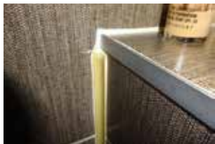
Plastová lišta s hliníkovým profilem se nedají dobře napojit.
