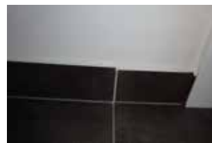
Nepovedený sokl zhotovitel vymění.
