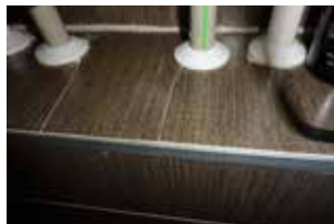
Otvory pro potrubí se prováděly dodatečně. Prasklé obklady nikdo nevyměnil.
